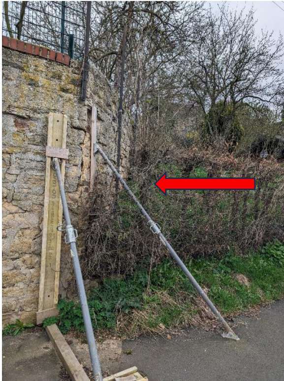
Abbildung 4: Verformung (Ausbuchtung) Südbereich
