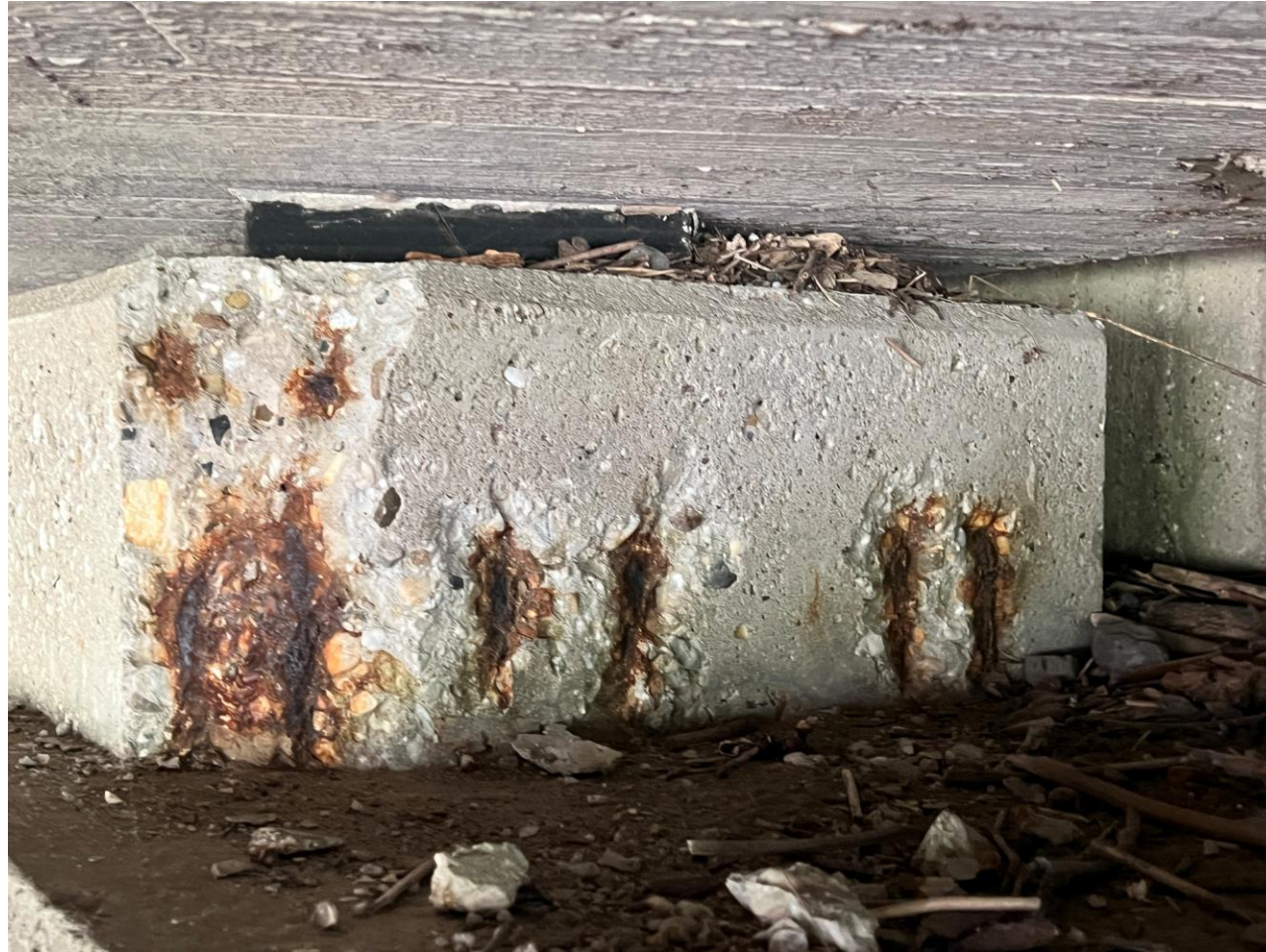
Abb. 14: Schadstelle Lagersockel Nord
