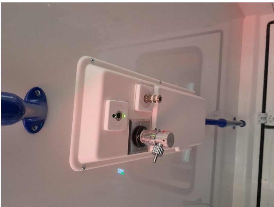
Deckencenter mit Gregersendose und Walther Steckdose
