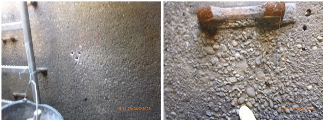
Bild 9: Bereich mit kuppenartig freiliegender Gesteinskörnung an einer Wand von Bauwerk S
