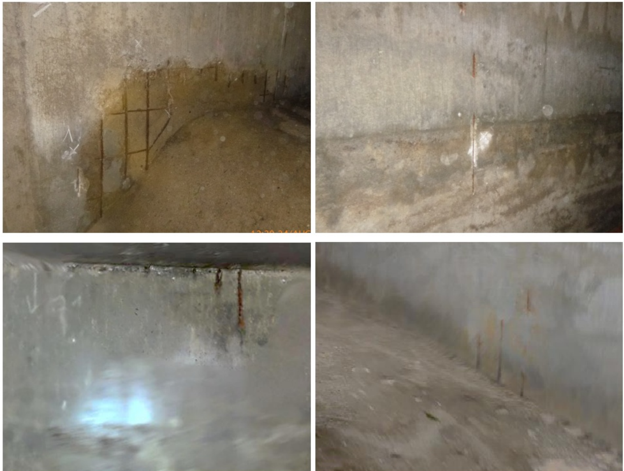
Bild 2: Beispiele für Abplatzungen mit freiliegender korrodierter Bewehrung an Wänden von Bauwerk RÜ1
