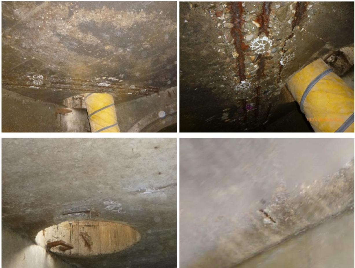
Bild 3: Beispiele für Abplatzungen mit freiliegender korrodierteter Bewehrung an der Deckenuntersicht von Bauwerk RÜ1
