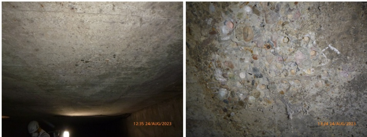
Bild 4: Beispiele für bereichsweise an der Deckenuntersicht von Bauwerk RÜ1 vorhandene kuppenartig freiliegende Gesteinskörnung und minderfester Beton
