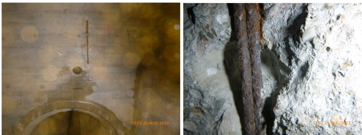
Bild 5: Aufnahmen einer Abplatzung an einer Wand von Bauwerk RÜ2
