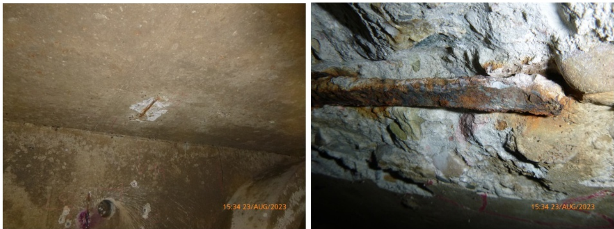
Bild 8: Abplatzung mit freiliegender, korrodierender Bewehrung an der Decke von Bauwerk S
