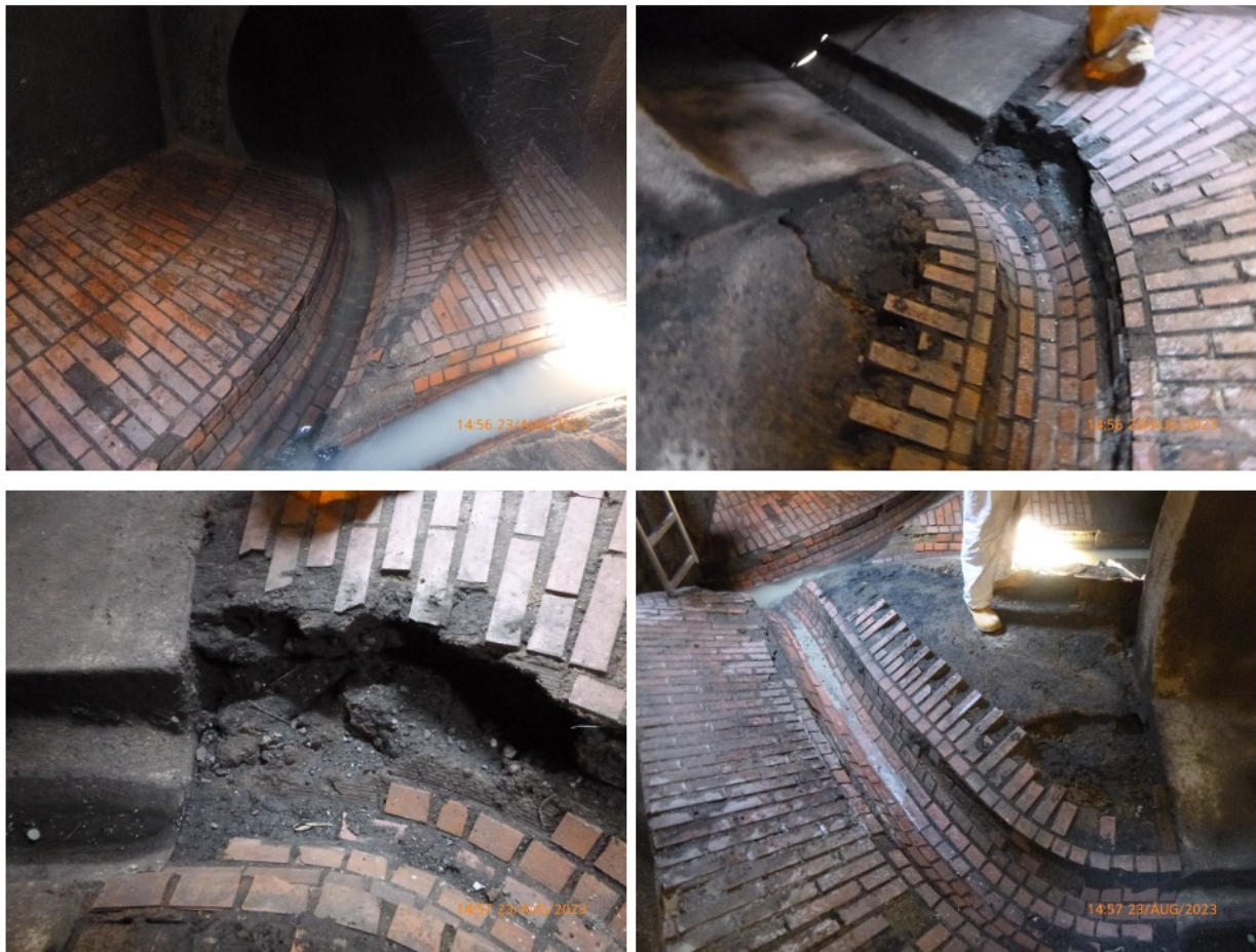
Bild 10: Beispiele für Bereiche mit abgängigen bzw. fehlenden Kanalklinkern an den Rinnen und Schwellen von Bauwerk S
