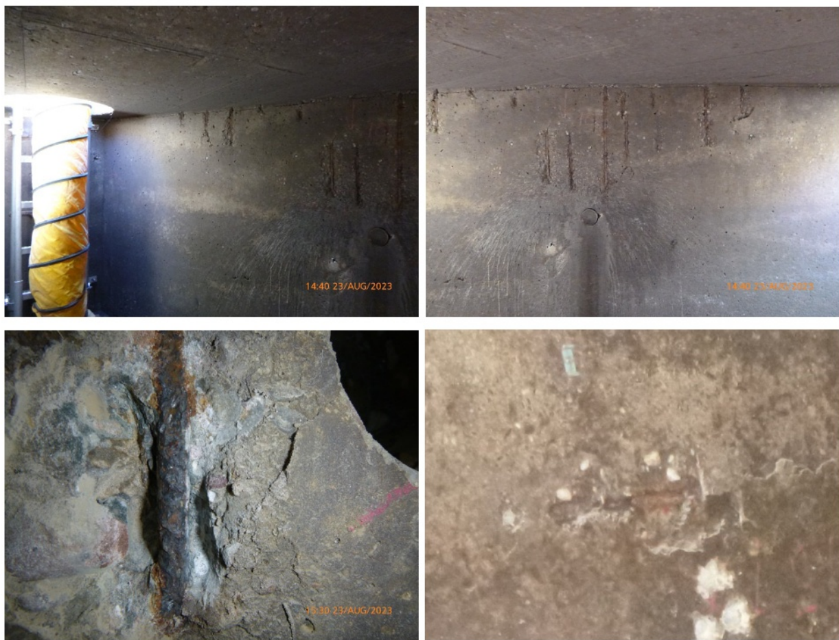
Bild 7: Beispiele für Abplatzungen mit freiliegender, korrodierte Bewehrung an Wänden von Bauwerk S
