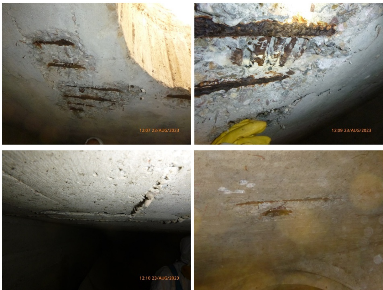
Bild 6: Beispiele für Abplatzungen freiliegender, korrodierteter Bewehrung und Hohllagen an der Decke von Bauwerk RÜ2
