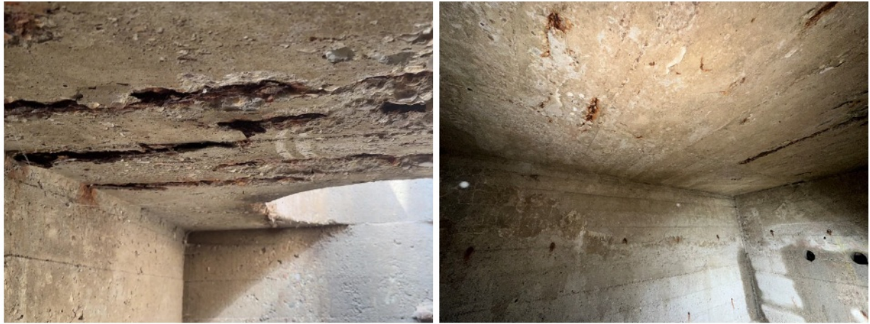
Bild 2: Beispiele für Betonabplatzungen an der Decke
