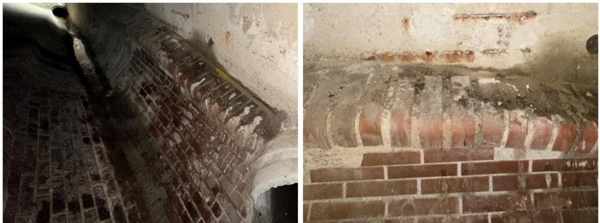
Bild 3: Beispiele für intakte Kanalklinker mit stellenweise brüchigem Fugenmörtel
