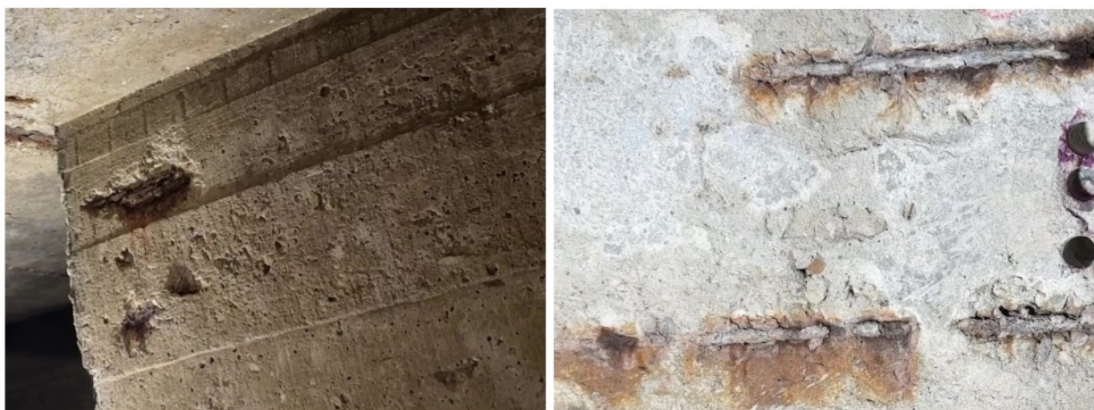
Bild 1: Beispiele für Betonabplatzungen an Wänden
