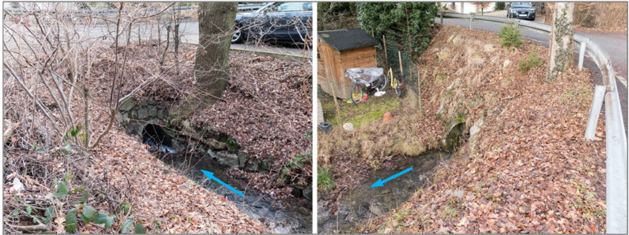
Abb. 2-1: Durchlass Steinacker im Bestand – links: Einlauf, rechts: Auslauf – DN 800
