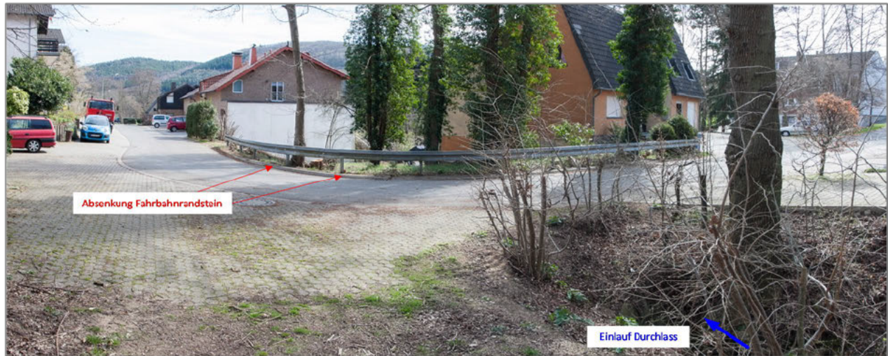
Abb. 2-7: Absenkung Fahrbahnrandsteine
